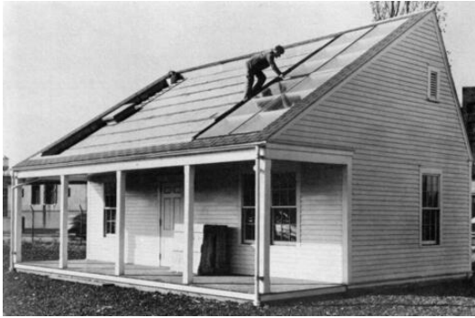
Figure 22 Image showing MIT Solar House 1.
