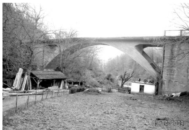
Slika 4. Izgled mosta sa nizvodne strane
